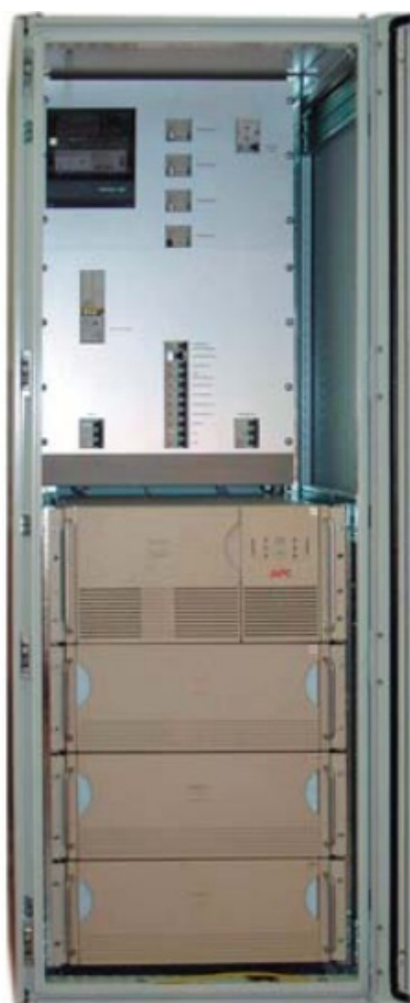
Рисунок 4 – Щит распределительный
