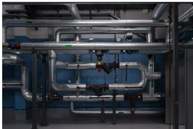
Рисунок 1 – Тепловая изоляция на трубах ЦТП
