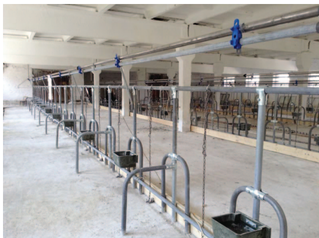
Рисунок 1 – Использование толстостенной оцинкованной вакуумной трубы ДУ40 гарантирует надежную работу молокопровода – трубы не провиснут через полгода
