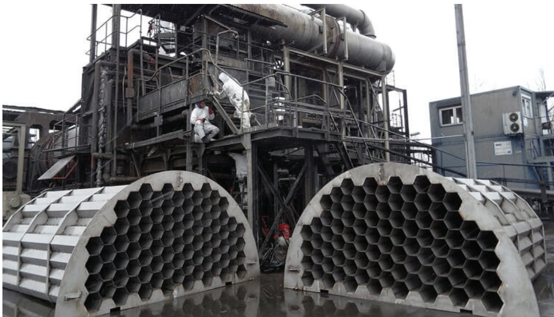
Рисунок 3 – Электропреципитатор, ремонт на участке инсинерации мусора (хорошо видны трубчатые сотообразные электроды)
