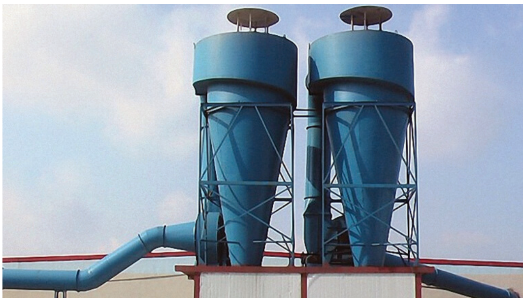
Рисунок 2– «Циклоны» на крыше здания
