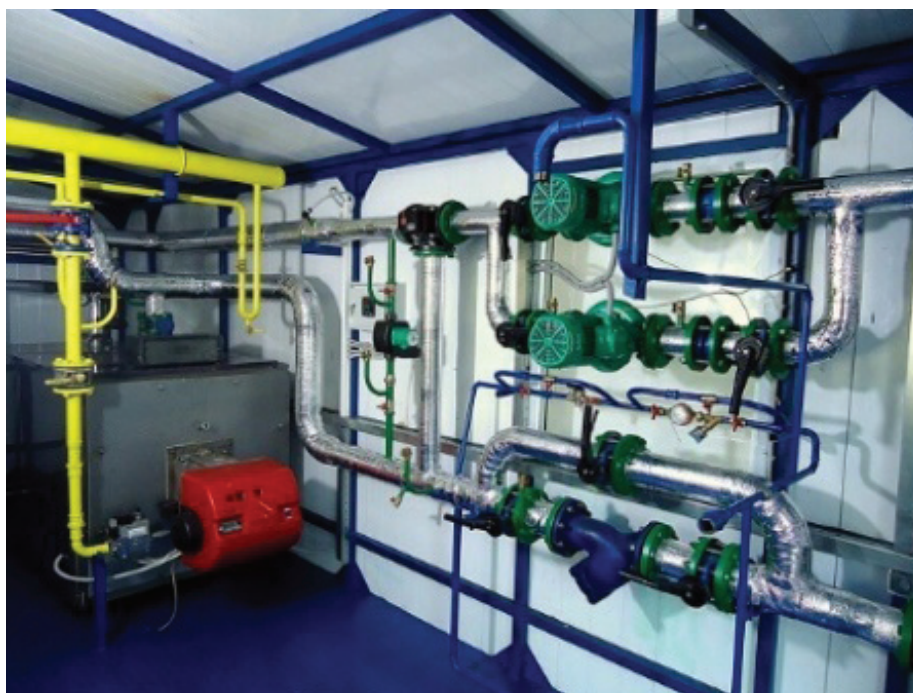
Рисунок 2 – Группа насосов в котельной
