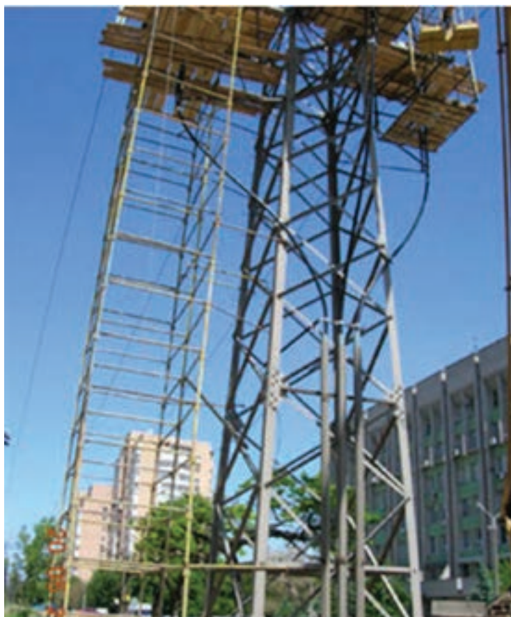
Рисунок 3 – Защита кабеля металлическими трубами
