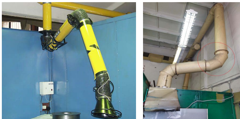
Рисунок 5 – Подъемно-поворотное вытяжное устройство и место для его монтажа
