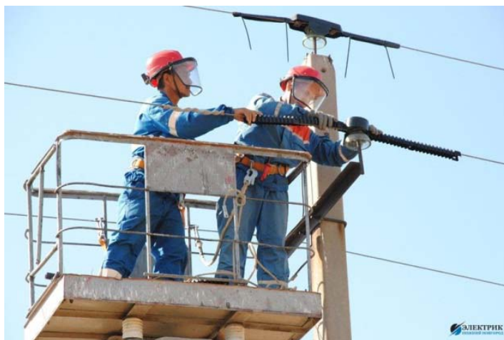
Рисунок 3 – Подъём на опору ВЛ
