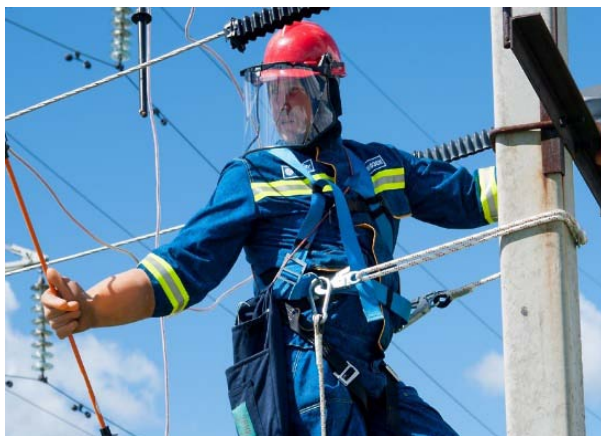
Рисунок 1 – Монтаж воздушной линии
