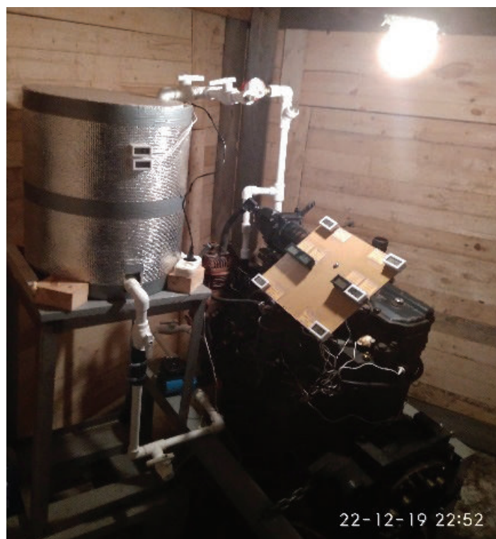
Рисунок 1 – Стенд для испытания теплового аккумулятора
