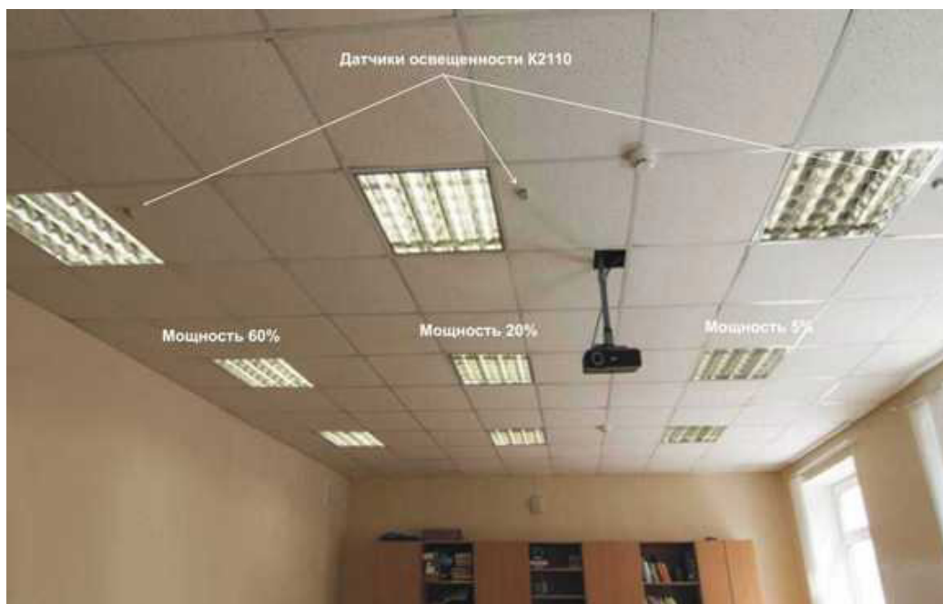
Рисунок 6 – Пример расположения датчиков в учебном классе
