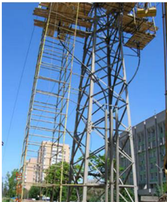
Рисунок 3 – Защита кабеля металлическими трубами
