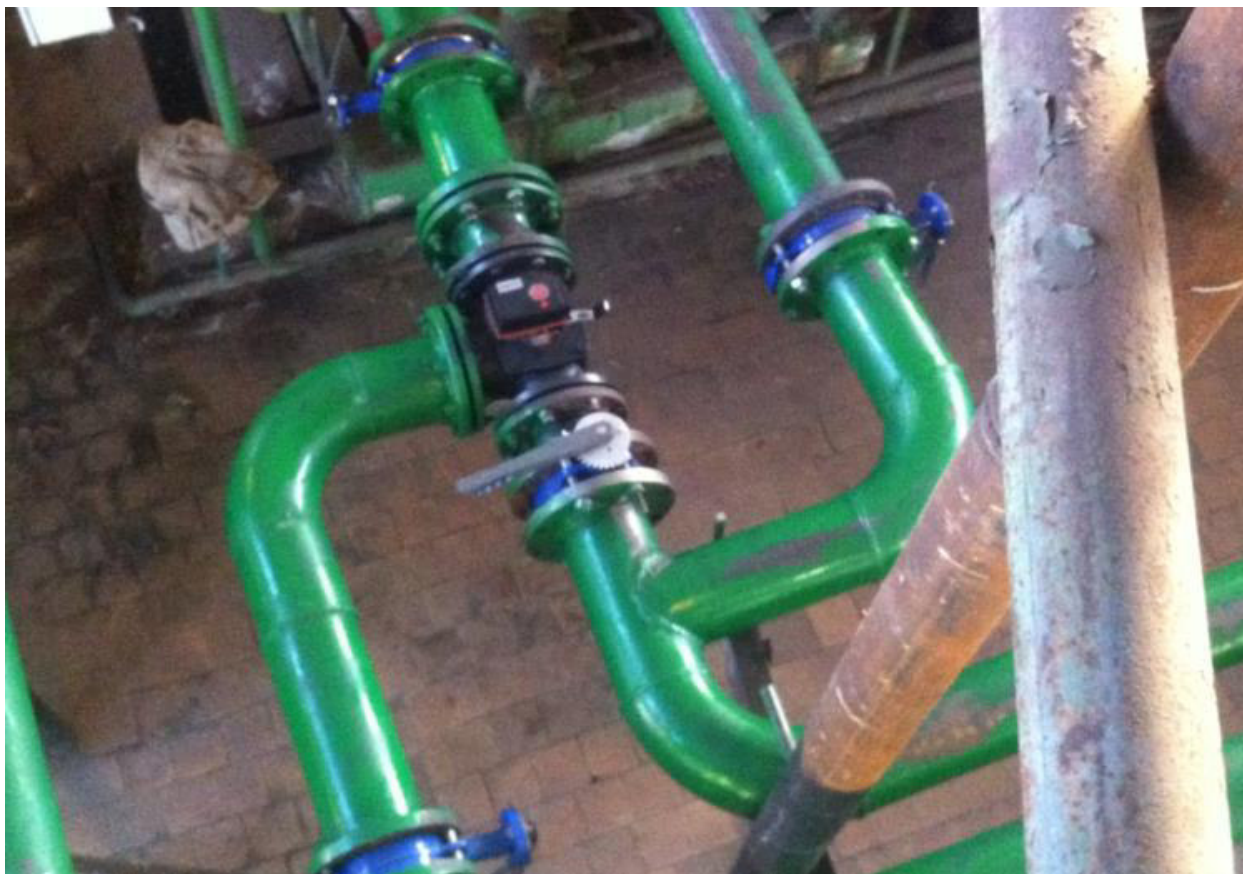
Рис.4 – Схема узла погодного регулирования в тепловом пункте
