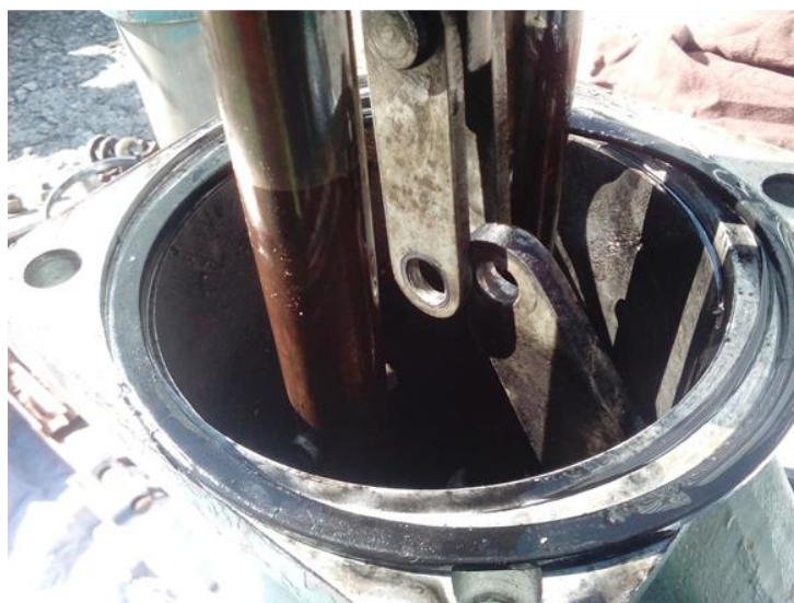
Рисунок 2 – Выпрямляющий механизм подвижного контакта МВ
